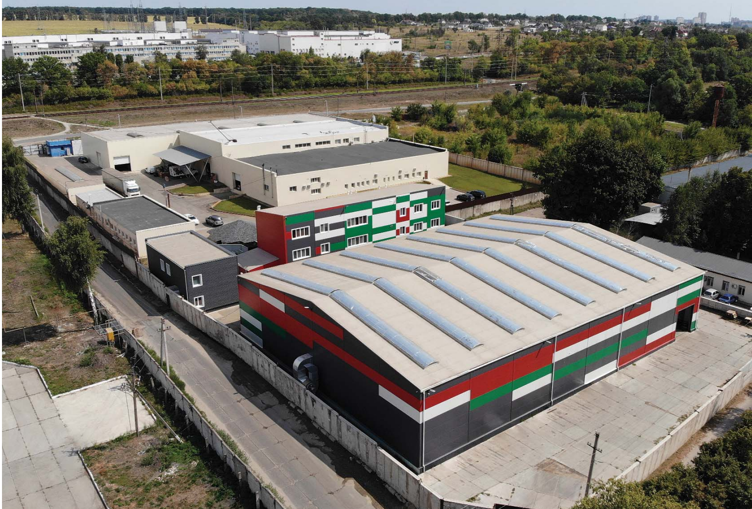
Территория компании «ГРАНД ИНСТРУМЕНТ» в г. Харьков. На заднем плане - складские строения. В центре - офисное здание. На переднем плане - возведенный цех завода по производству оборудования для автосервиса.
