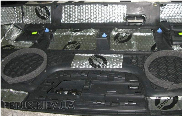
Вибропоглощение задней полки в Peugeot 301 выполнено локально с использованием легкого Ultimate Construct A1
