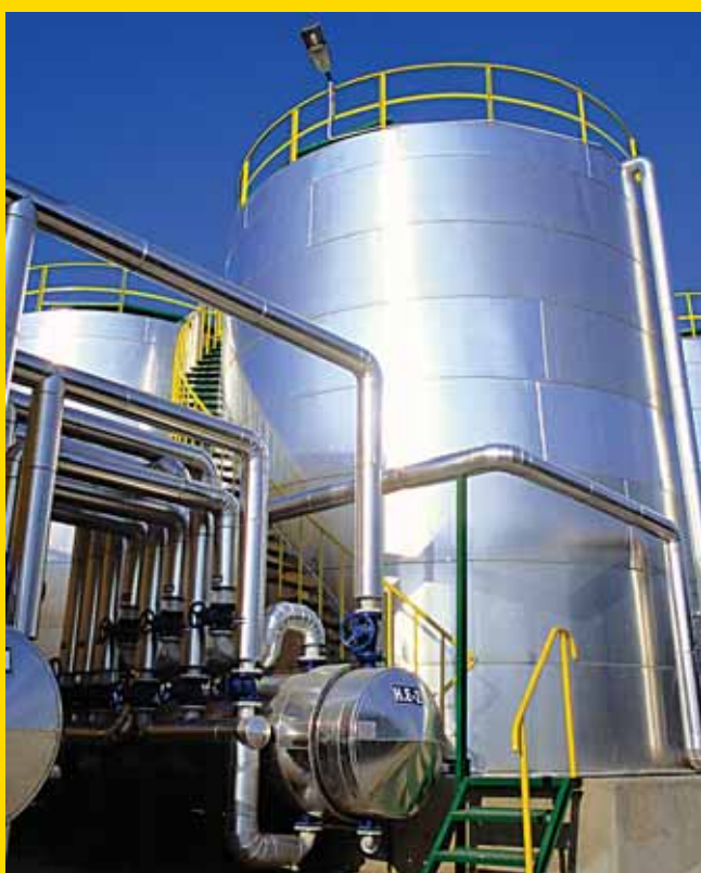
На территории хранится относительно небольшое количество базовых масел – порядка 7000 тонн. Основной запас, в районе 24 000 тонн, хранится в терминале в Варне. Присадки приходят в 200-литровых бочках или в цистернах. Базовые масла попадают в производственную зону по трубам.
