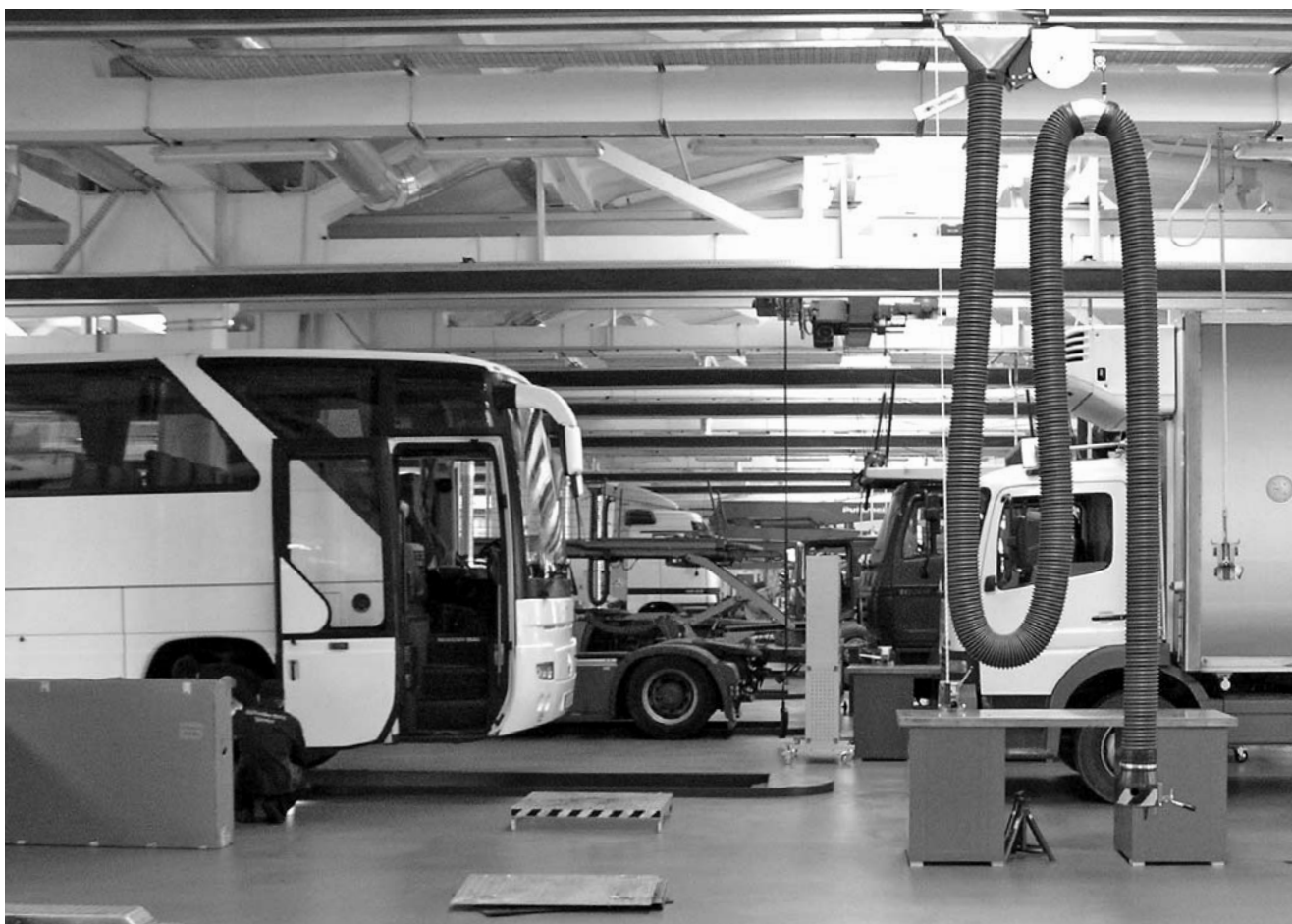
Ввиду удобного расположения и возможности обслуживать автомобили разной длины на СТО "Атлант" используется именно рельсовая СГУ.
