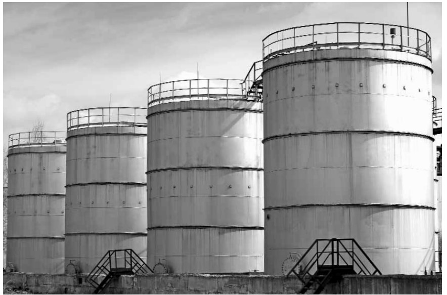
Резервуарный парк предприятия позволяет осуществлять прием и хранение 5 000 тонн готовых и базовых масел.
