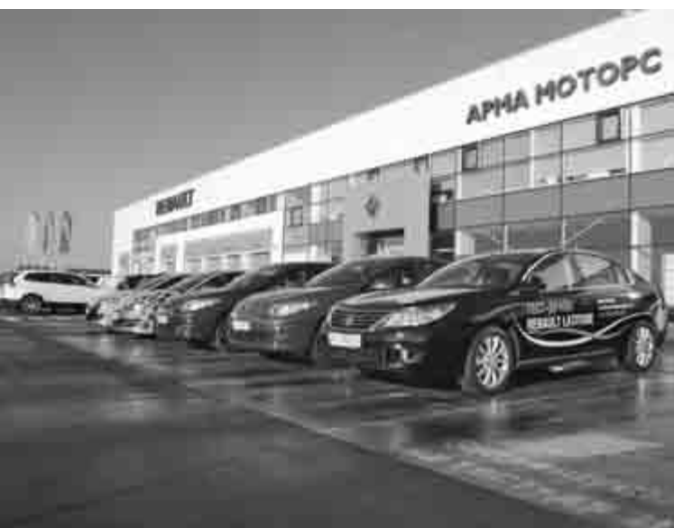
«Сердце» компании «Арма Моторс» - комплекс Renault. Справа расположен автосалон, слева - въезды в сервисную зону, на мойку, тестовую линию и подземный паркинг на 200 автомобилей, здесь же расположены склад и кузовной цех.
