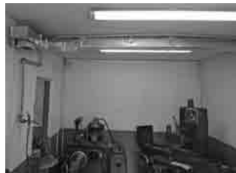
Температура на производственных участках должна быть не ниже 15 градусов. На ночь котел отключают, а утром он нагревает помещение в течение получаса.
