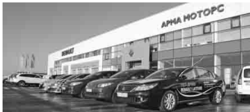
«Сердце» компании «Арма Моторс» - комплекс Renault. Справа расположен автосалон, слева - въезды в сервисную зону, на мойку, тестовую линию и подземный паркинг на 200 автомобилей, здесь же расположены склад и кузовной цех.
