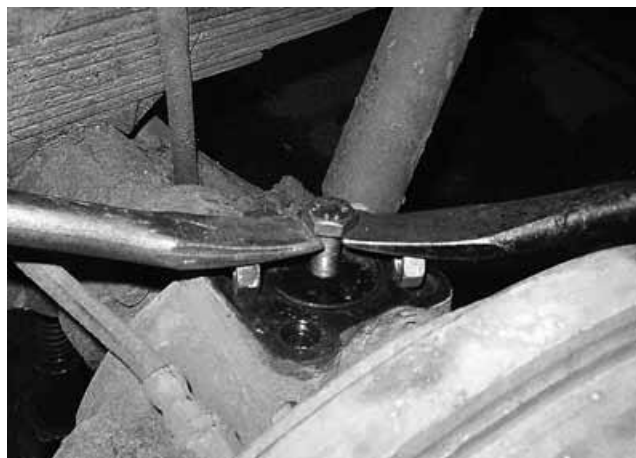
Фото 3. Извлечение старого шкворня
