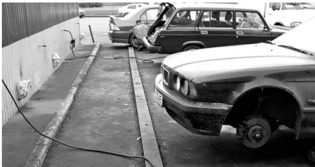
Подвод сжатого воздуха и освещение рабочих мест снятия и установки колес.
