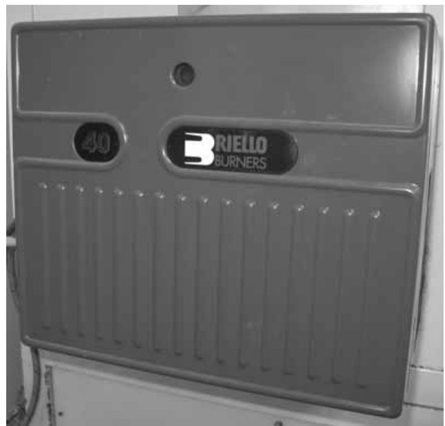
Оборудование под некоторыми китайскими брендами оснащается западными агрегатами: например, в камерах Yoki Star установлены горелки итальянской фирмы Riello.
