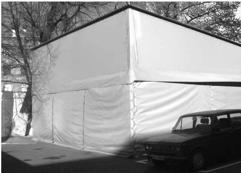
Тентовый склад для аварийных автомобилей.
