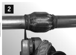
14 По обозначенному месту (за сварным швом) отделить старую трубу с гофрой.
