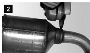
2 По обозначенному месту (за сварным швом) отделить старую трубу с гофрой.
