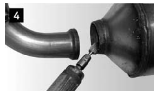
4 Сварной шов отфрезеровать механическим абразивным инструментом до полного очищения от остатков старой трубы.
